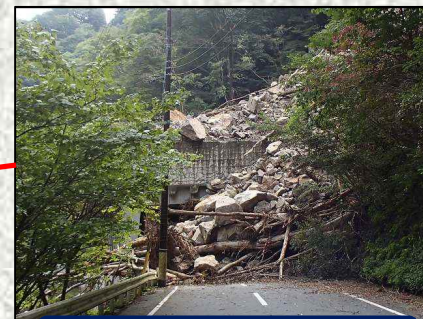
道路を塞いだ岩塊（上流側）
